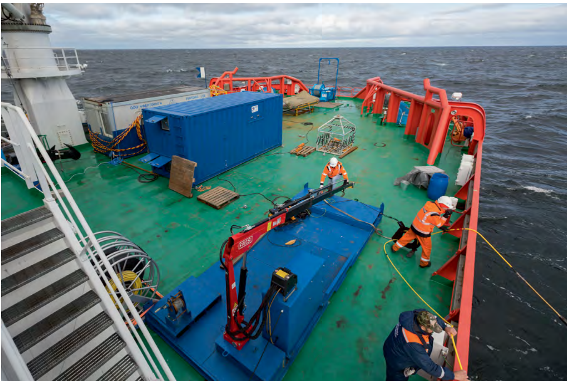
ВЫПОЛНЕНИЕ РАБОТ ПОД ВОДОЙ МФАСС «Балтика»
