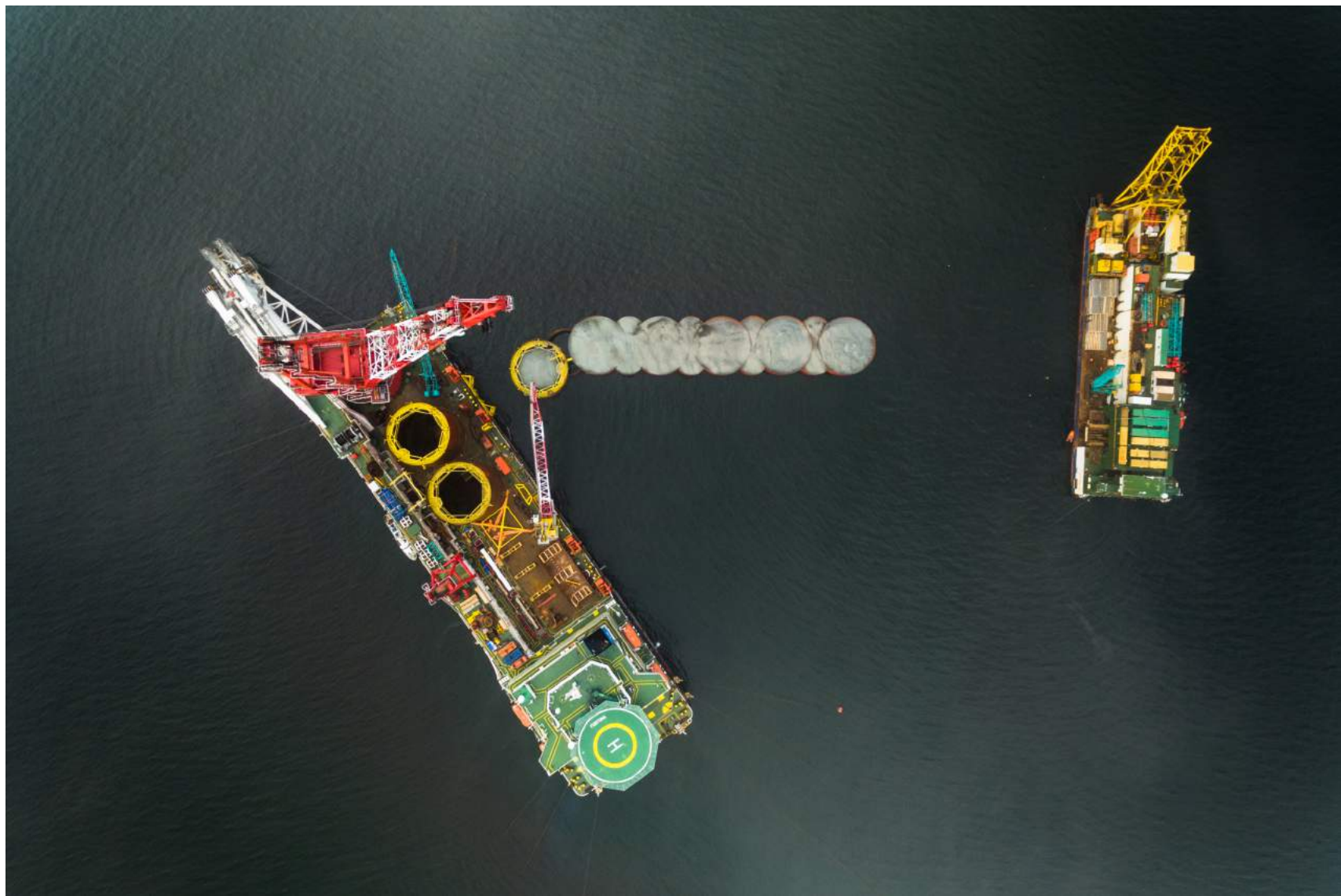
Установка оболочек большого диаметра волнолома терминала регазификации БАЛТИЙСКОЕ МОРЕ
