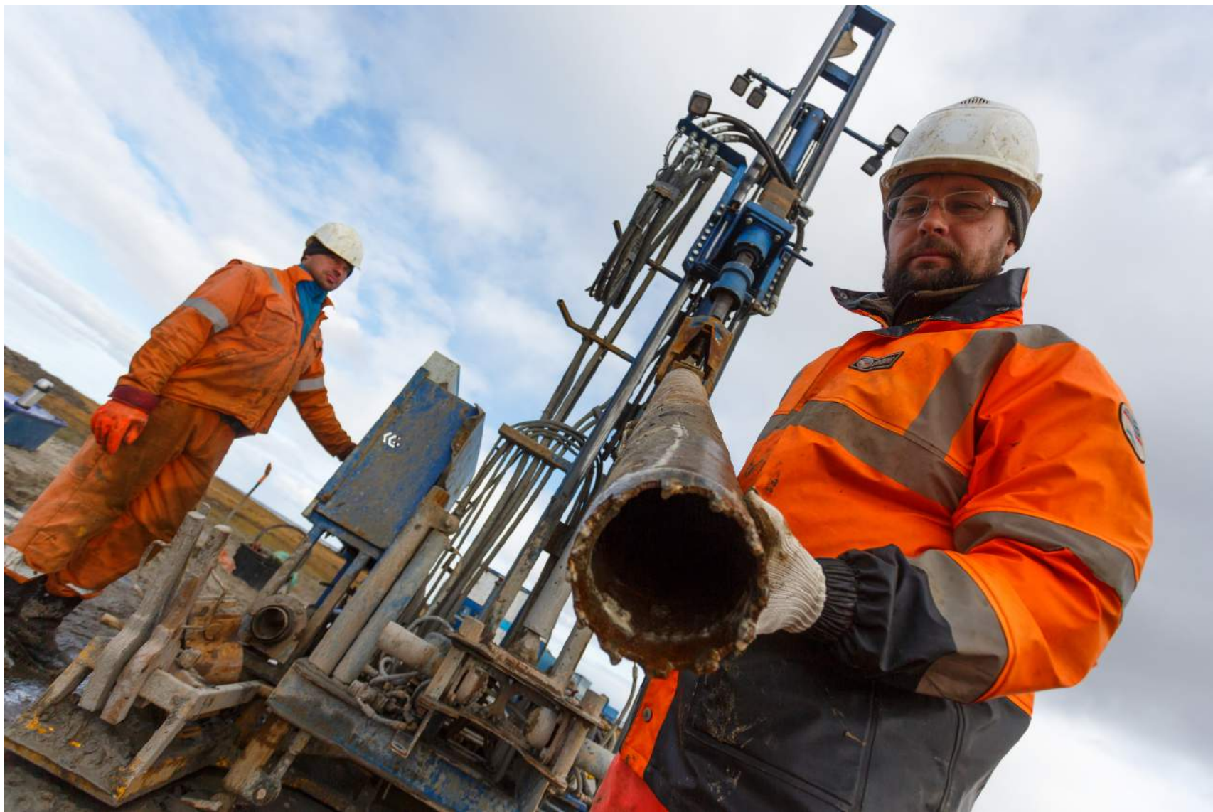
Строительство антенно-мачтового сооружения автоматизированного радиотехнического поста (АРТП) ОБСКАЯ ГУБА, ПОЛУОСТРОВ ЯМАЛ
